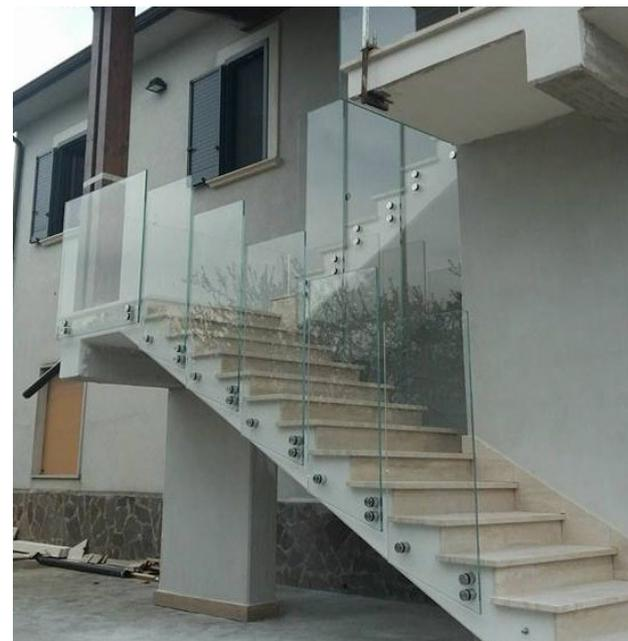
L'eccezione sono le **SCALE NON COMUNI**...interne o esterne ai fabbricati e di larghezza non superiore a **1.20 m**, per le quali è consentita la progettazione e l'installazione di parapetti calcolati a **100 kg/m**
